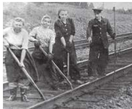
Ремонт пути в районе станции Котик. Вторая слева В.П. Баранова, 1956 год
