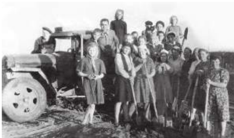
Жители поселка Будагово на строительстве автодороги, 1950-е годы
