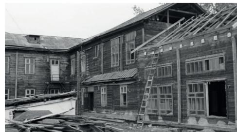
Сейчас строители заняты ремонтом крыши, восстановлением перекрытий. Они в прямом смысле слова перебирают каждый сантиметр кровли. Уже частично залит фундамент, сняты ветхие полы. «От графика не отстаем», - отметили подрядчики.
