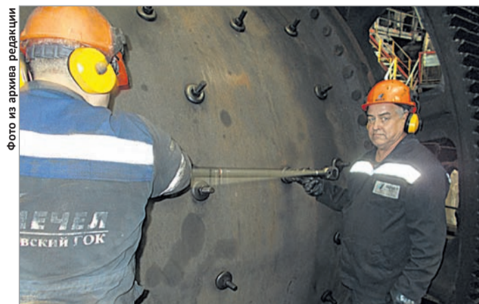
Обтяжку болтовых соединений броней цилиндра мельницы выполняют слесари-ремонтники отделения по ремонту фабричного оборудования-2
