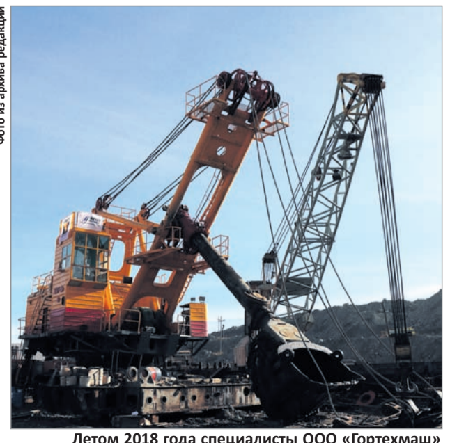
Летом 2018 года специалисты ООО «Гортехмаш» капитально отремонтировали два экскаватора в Коршунновском карьере и на Рудногорском руднике
