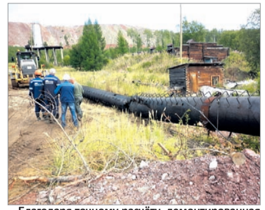
Благодаря точному расчёту, демонтированная дымовая труба «легла» на землю точно так, как было спрогнозировано
