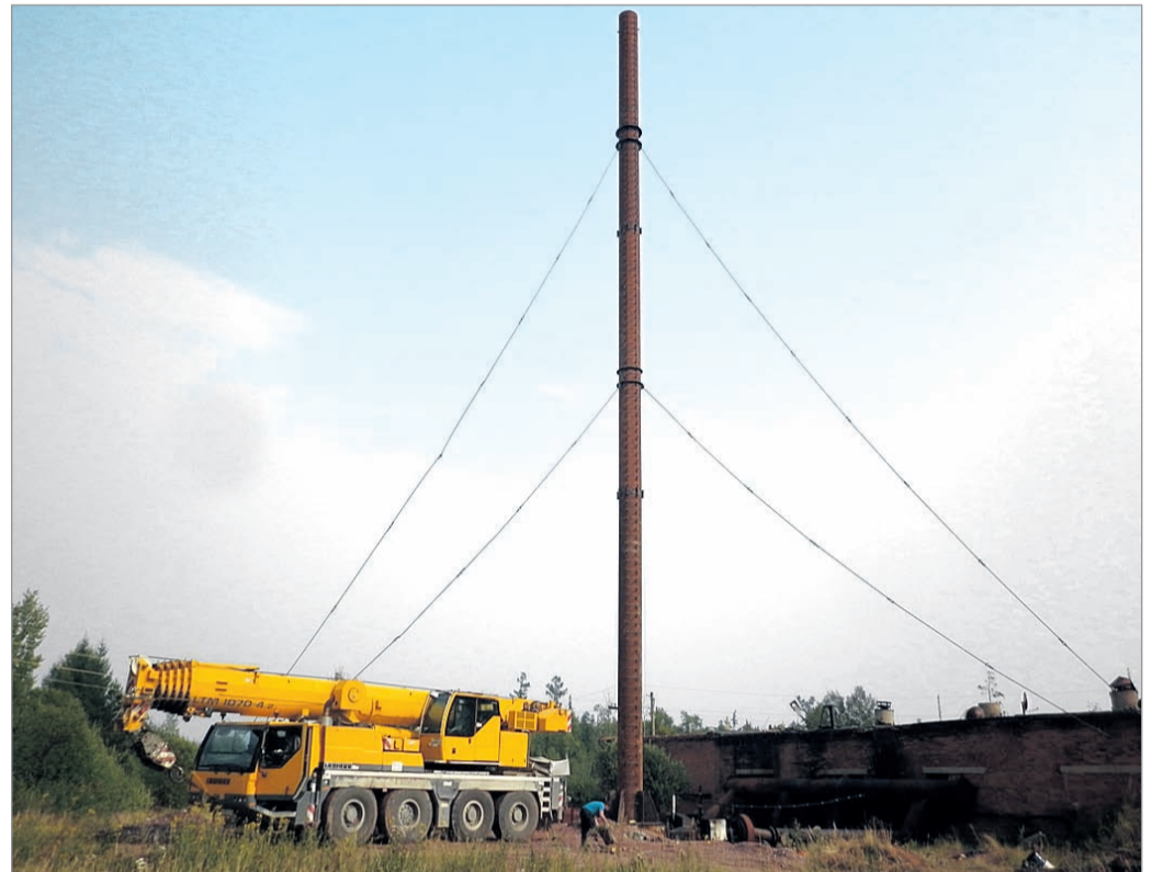
При помощи автокрана Liebherr 32-метровую трубу установили в проектное положение
