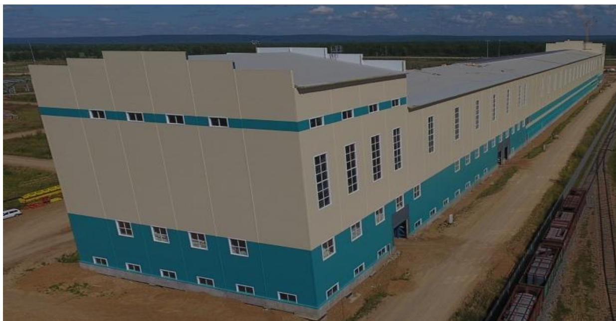
Рис. 1.1-1. Реализация первого этапа строительства Тайшетской Анодной фабрики. Корпус обжига анодов № 1 (общий вид)
