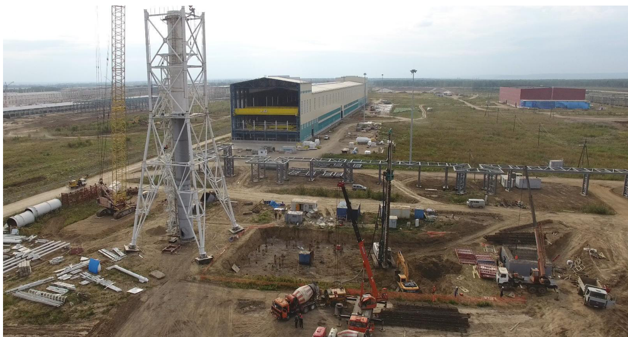
Рис. 1.1-2. Реализация первого этапа строительства Тайшетской Анодной фабрики. Строительство газоочистной установки печей обжига анодов.
