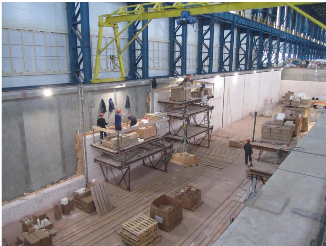
Рис. 1.1-4. Реализация первого этапа строительства Тайшетской Анодной фабрики. Печь обжига анодов № 1, производство футеровочных работ.
