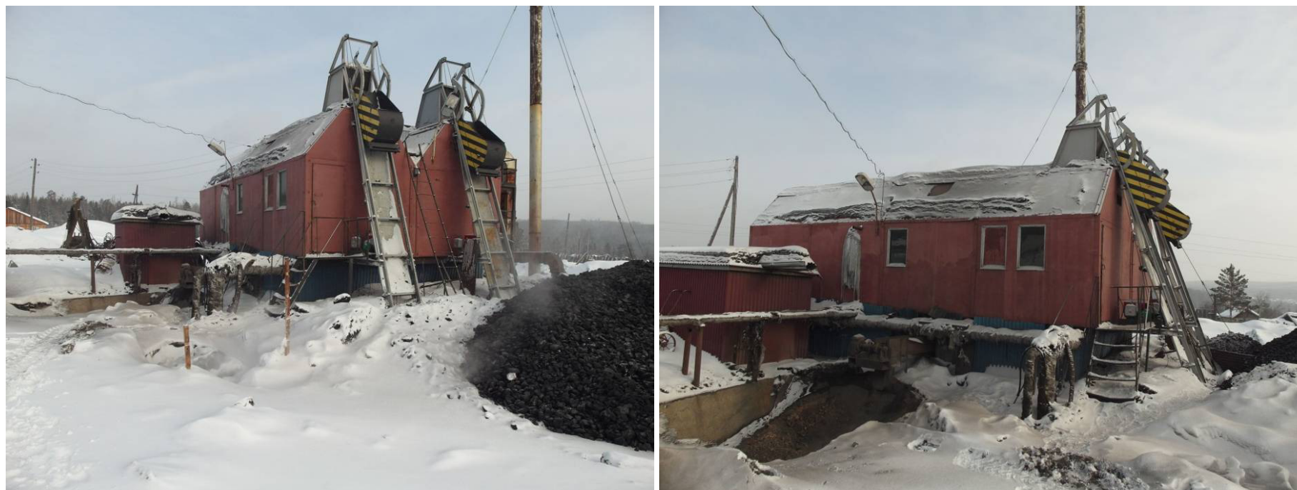
Рисунок 1 – Вид котельной, расположенной на территории п. Эдучанка Эдучанского сельского поселения
