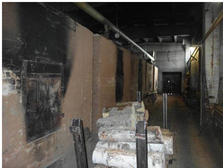
Рисунок 1 – Вид котельной, расположенной на территории с. Ершово
