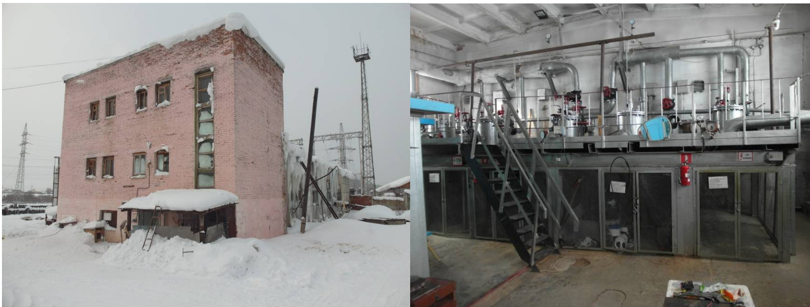
Рисунок 1 – Вид котельной, расположенной на территории п. Невон
