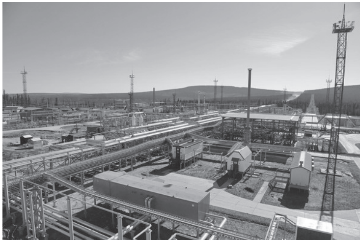
На Газовом промысле Ковыктинского ГКМ
