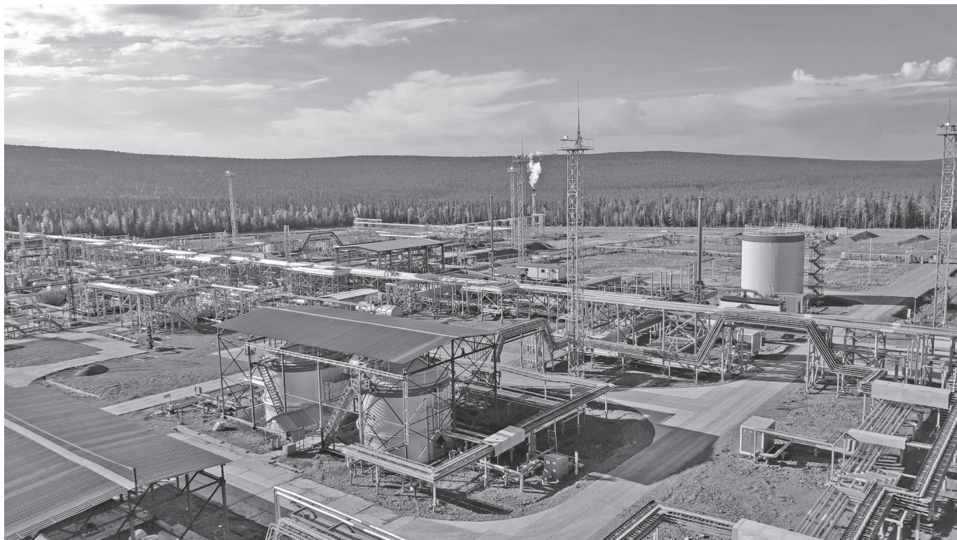
На Газовом промысле Ковыктинского месторождения
