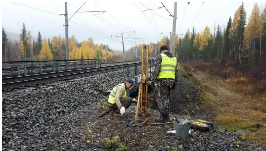
Рисунок 1.1 – Бурение скважин через тело насыпи.
