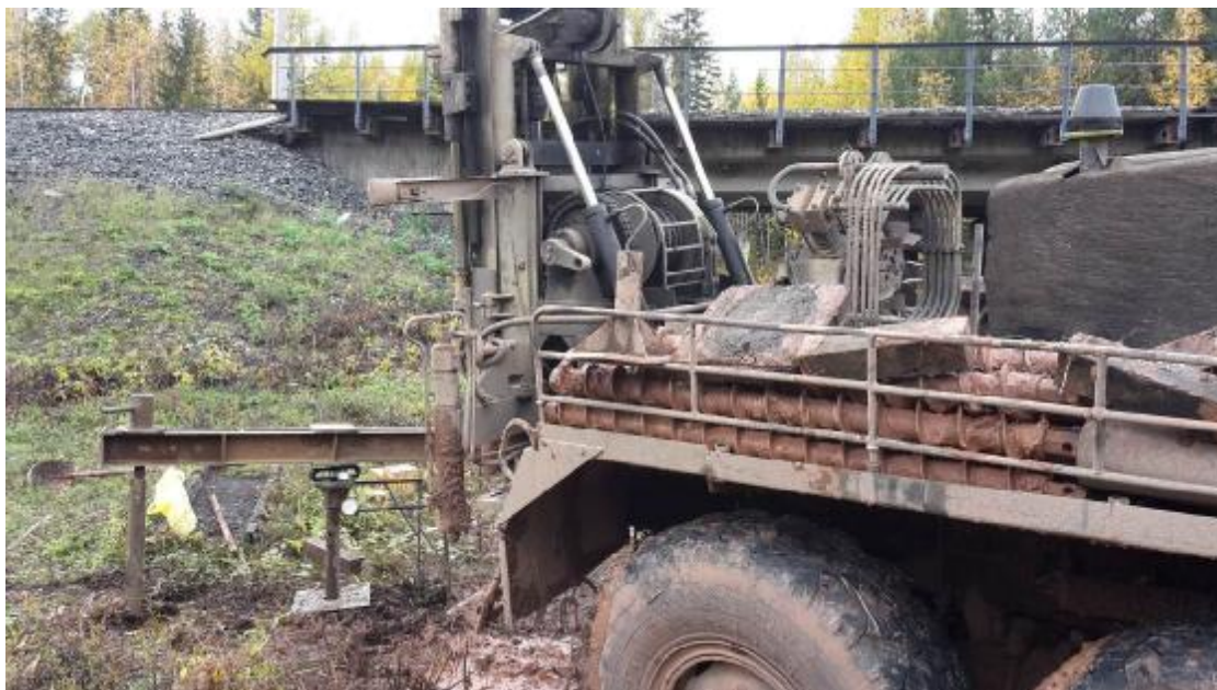
Рисунок 1.4 – Испытание грунтов штампами (статическими нагрузками)
