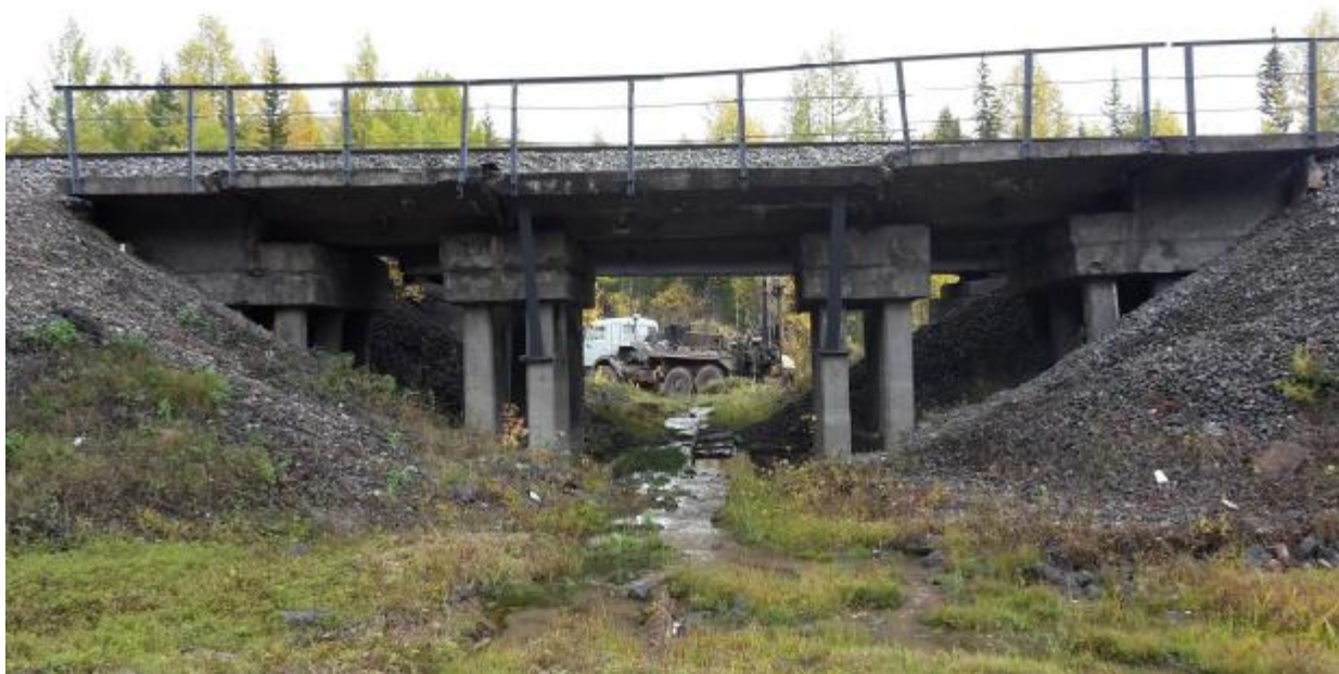
Рисунок 1.2 – Бурение скважин в основании насыпи.
