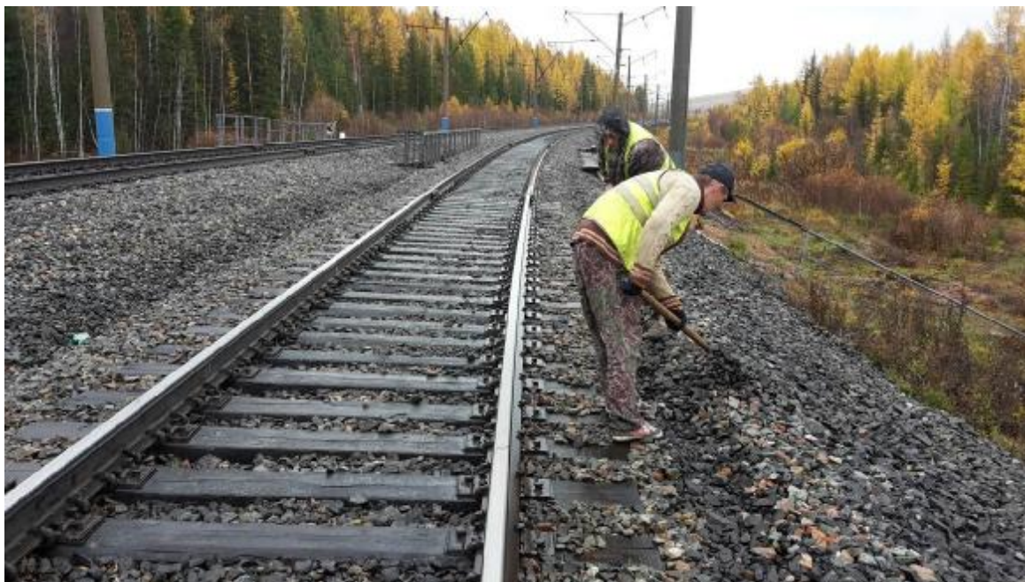
Рисунок 3.5 – Железнодорожные пути на ПК 6119+62,68
