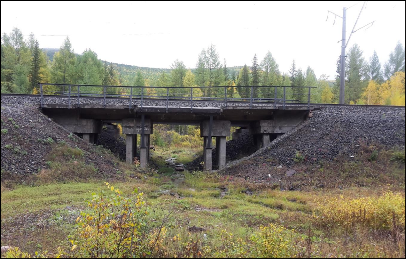
Рисунок 1.3 - Общий вид моста
