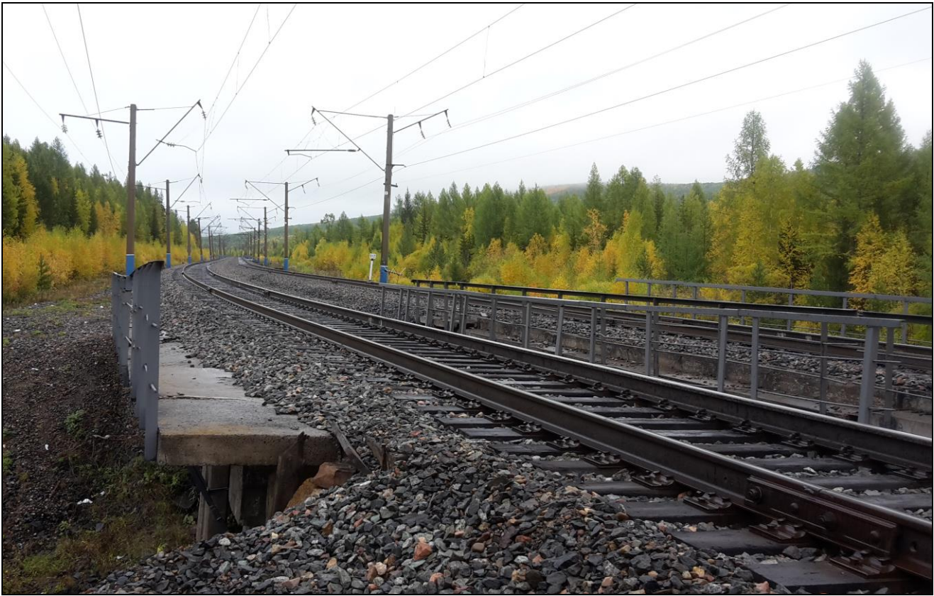
Рисунок 1.2 - Общий вид участка работ
