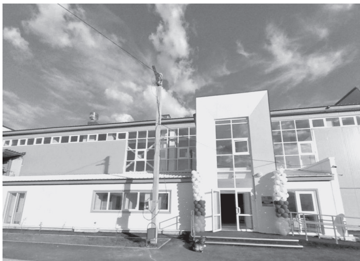
Завершилось строительство физкультурно-оздоровительного комплекса в Жигалово
