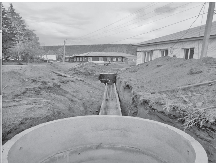
Проведен ремонт теплотрасс в районной больнице и центральной котельной
