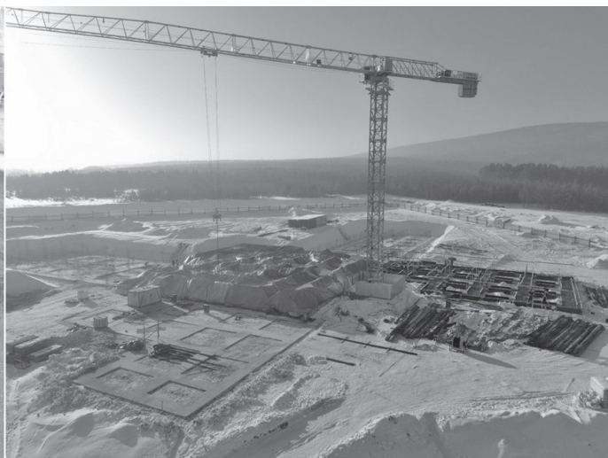
Начато строительство школы на 520 учащихся в Жигалово
