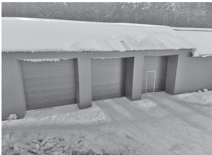
Проведен ремонт гаража автотранспортного предприятия
