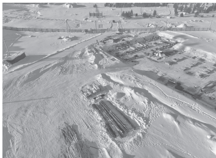
Начато строительство детского сада на 240 мест в Жигалово
