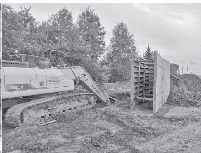
Началось строительство системы централизованного водоснабжения в Жигалово»
