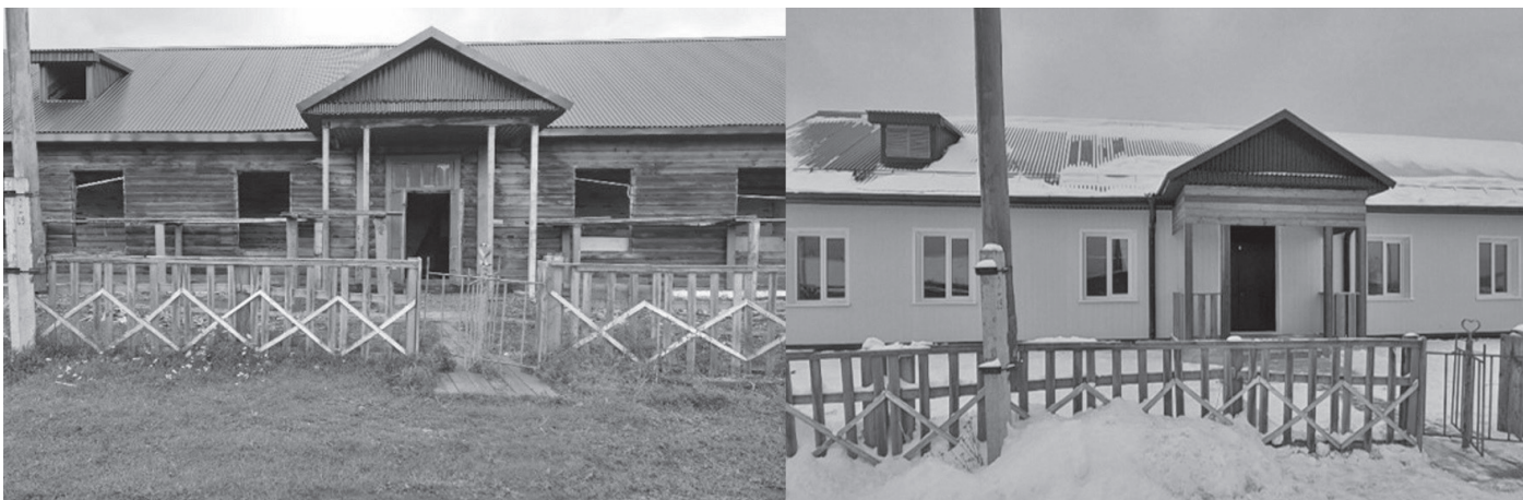
Знаменская средняя школа (до ремонта и после)
