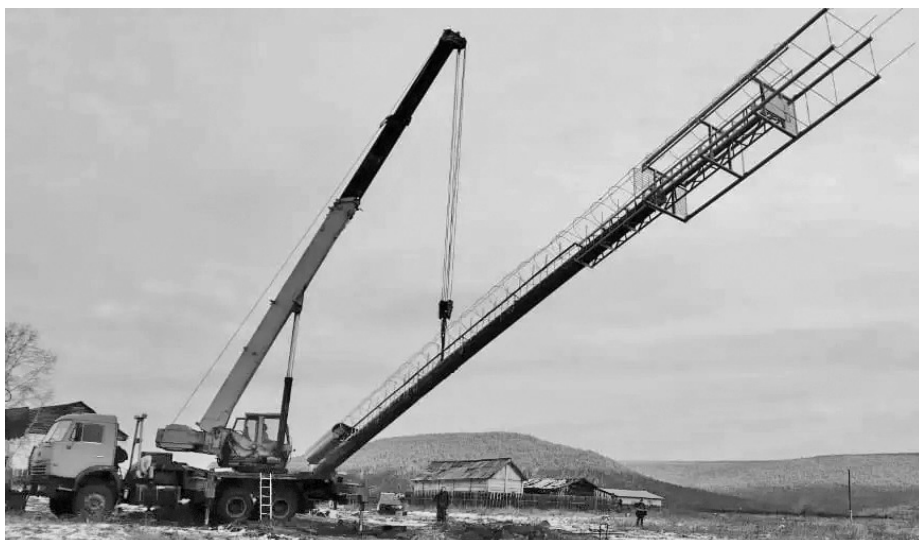
В 2025 году вышка сотовой связи установлена в селе Усть-Илга
