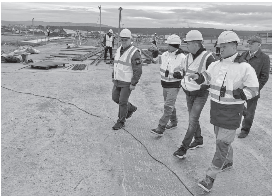
Межведомственная комиссия на строительной площадке
