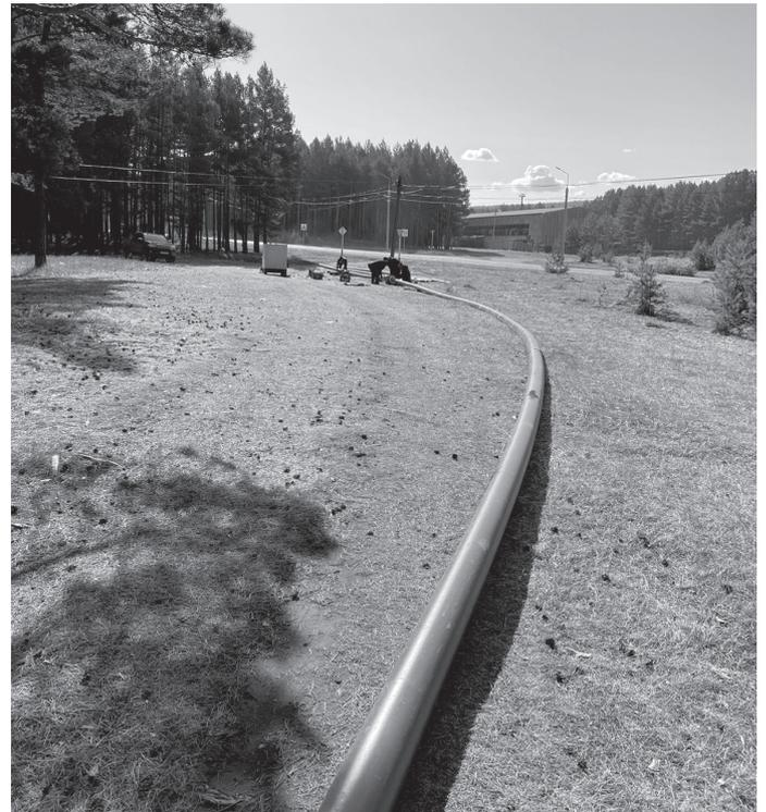
подготовительные работы, завезена спецтехника и материалы для выполнения строительно-монтажных работ, проложены первые 360 метров водопровода. В планах текущего года – строительство без подключения потребителей-домовладельцев и установка 15 водозаборных колонок.
